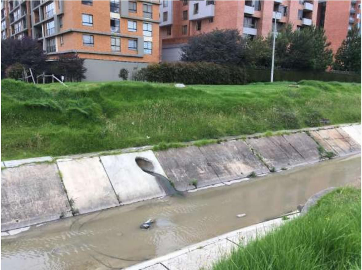
**Fotografía 7.** Punto de intervención en el cauce del canal El Cedro mediante la demolición y reconstrucción de un cabezal de entrega de alcantarillado pluvial en la margen izquierda aguas abajo del cuerpo de agua.
