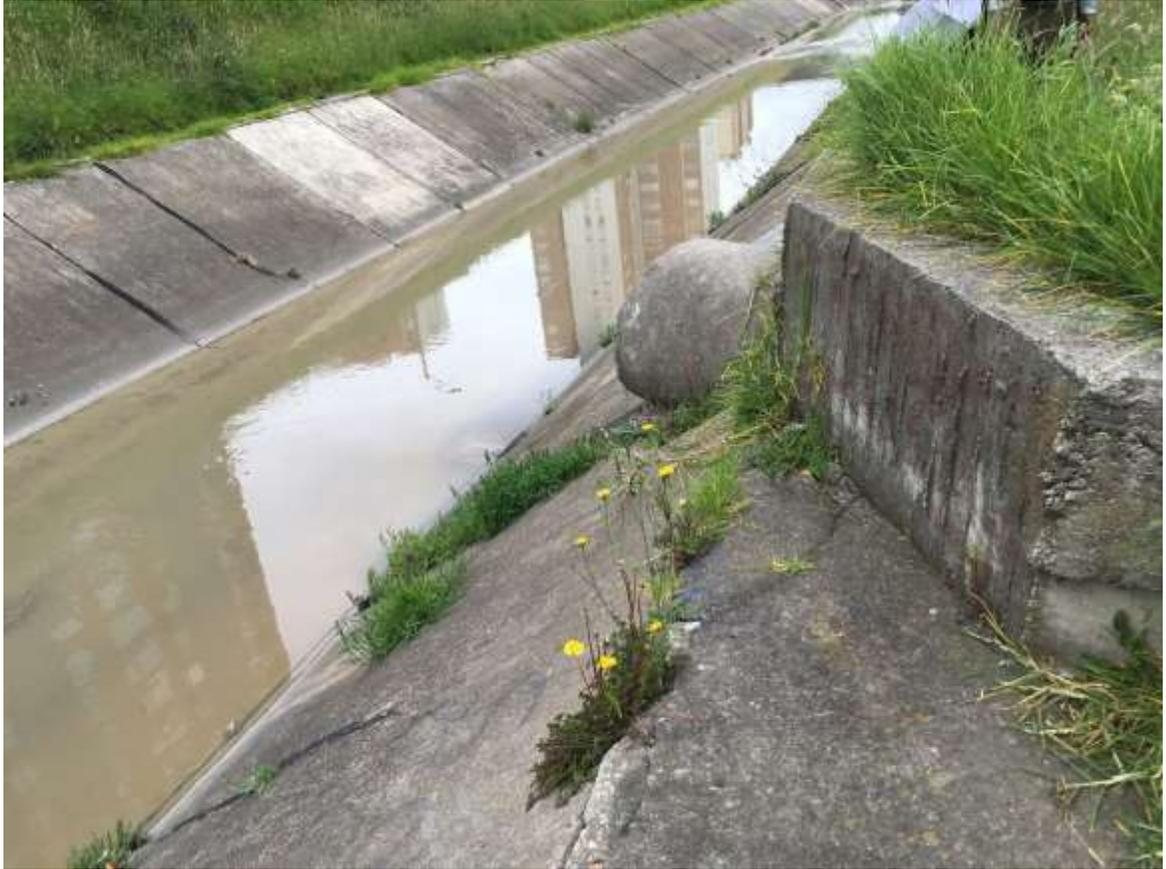
**Fotografía 9.** Punto de intervención en el cauce del canal El Cedro mediante la demolición y reconstrucción de un cabezal de entrega de alcantarillado pluvial en la margen derecha aguas abajo del cuerpo de agua.
