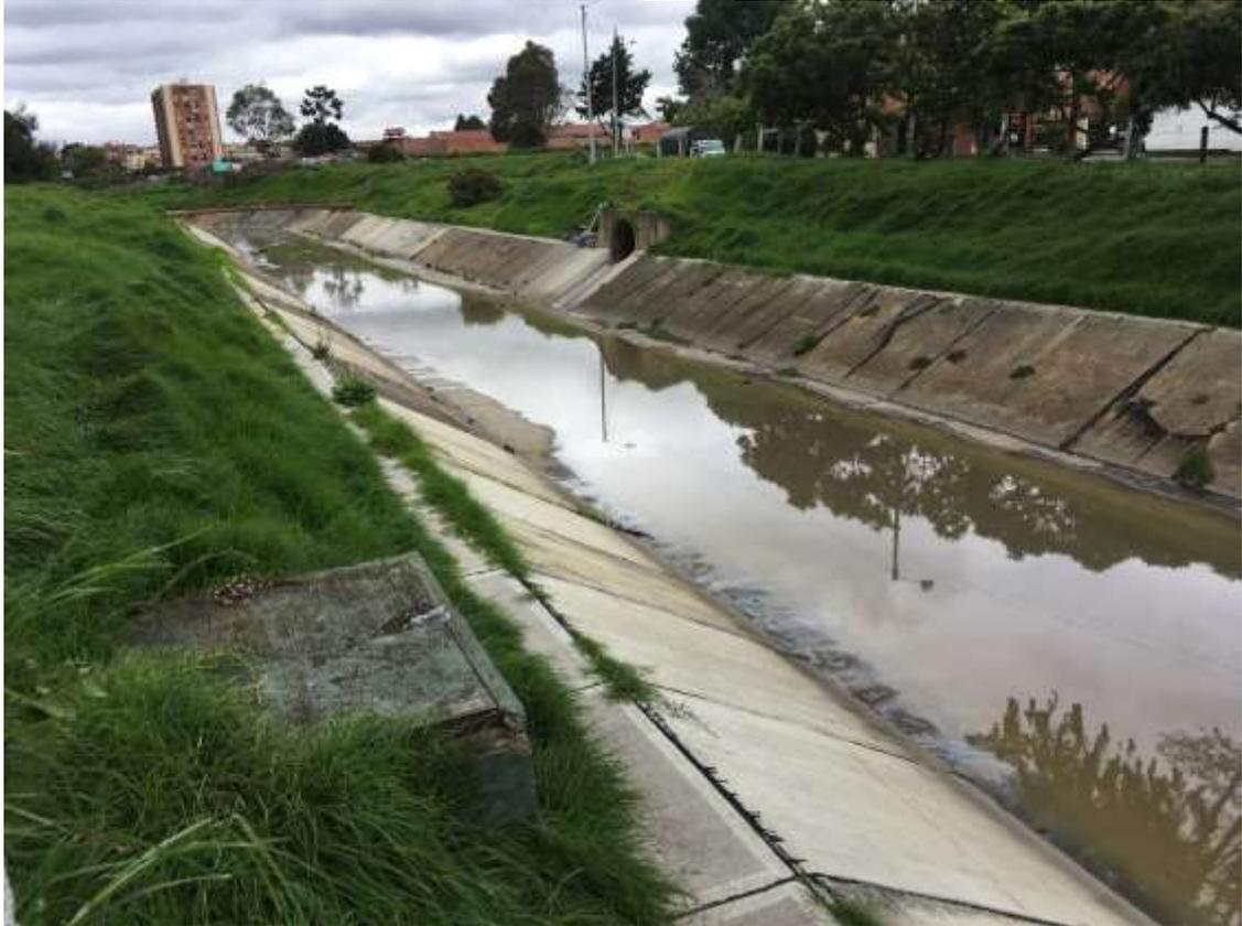
**Fotografía 15.** Punto de intervención en el cauce del canal El Cedro mediante la construcción de un nuevo cabezal de entrega de alcantarillado pluvial en la margen izquierda aguas abajo del cuerpo de agua.
