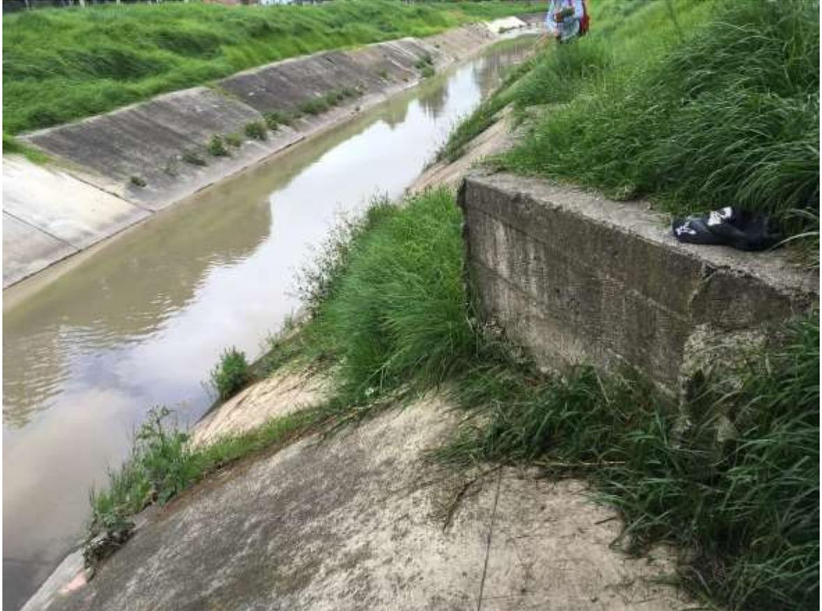
***Fotografía 11.** Punto de intervención en el cauce del canal El Cedro mediante la reconstrucción de un cabezal de entrega de alcantarillado pluvial en la margen derecha aguas abajo del cuerpo de agua.*
