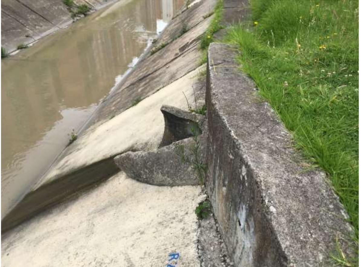
**Fotografía 8.** Punto de intervención en el cauce del canal El Cedro mediante la demolición y reconstrucción de un cabezal de entrega de alcantarillado pluvial en la margen derecha aguas abajo del cuerpo de agua.
