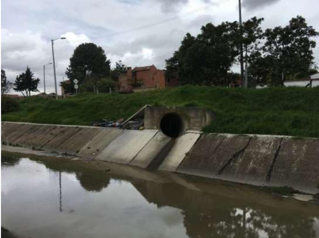
**Fotografía 14.** Punto de intervención en el cauce del canal El Cedro mediante la reconstrucción de un cabezal de entrega de alcantarillado pluvial en la margen izquierda aguas abajo del cuerpo de agua.
